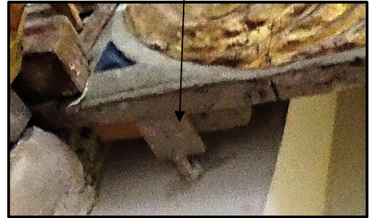
Fixation chimique de pattes de scellement de soutien.
