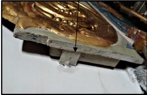
Fixation chimique de pattes de scellement de soutien.
