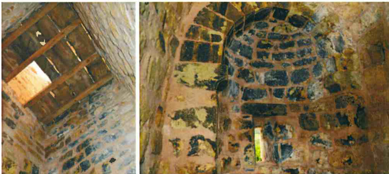
22-Vue sur les élévations intérieures du clocher
