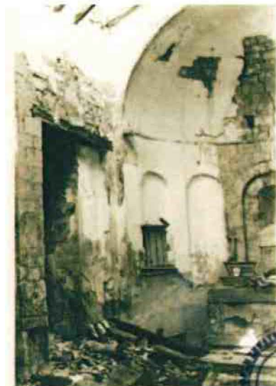
18-Vue de la porte d’accès au clocher et de l’absidele sud-ouest, 1942.
