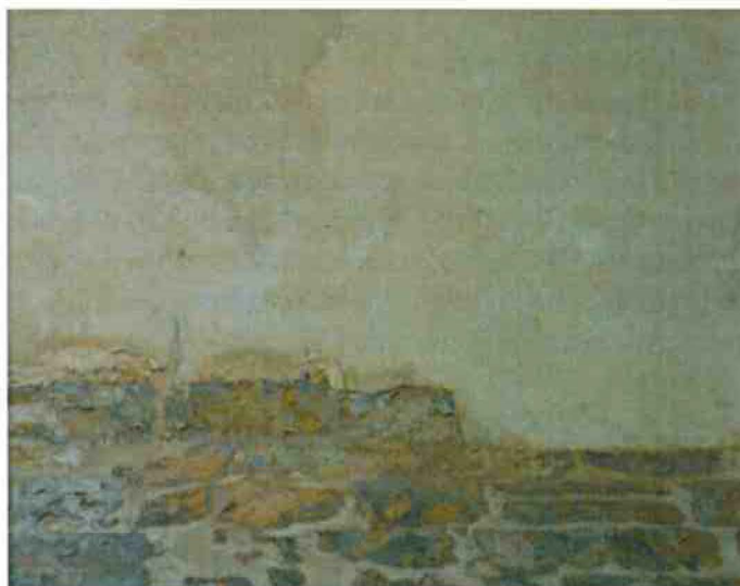
2-Pierres sculptées originelles en départ de voûte à l'origine de sa reconstitution en béton enduit à la chaux. Vue sur les maçonneries internes en blocage
