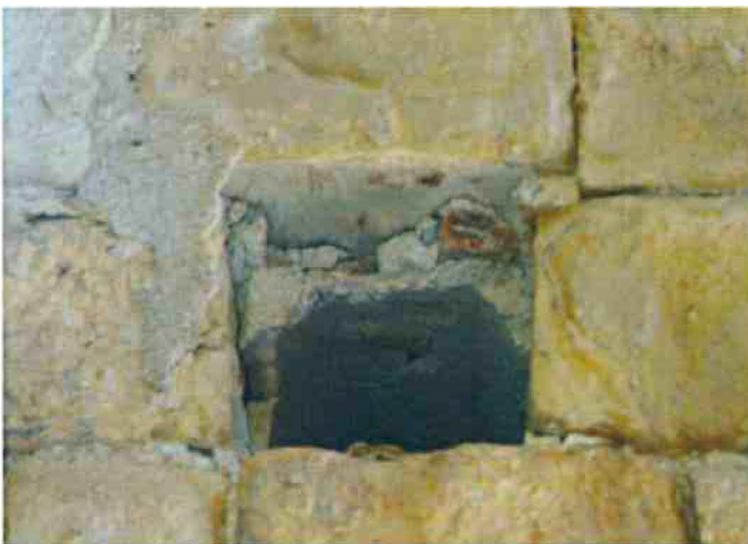
8-Vide dans les maçonneries créé par une pierre manquante dont on lit encore les joints au mortier.
