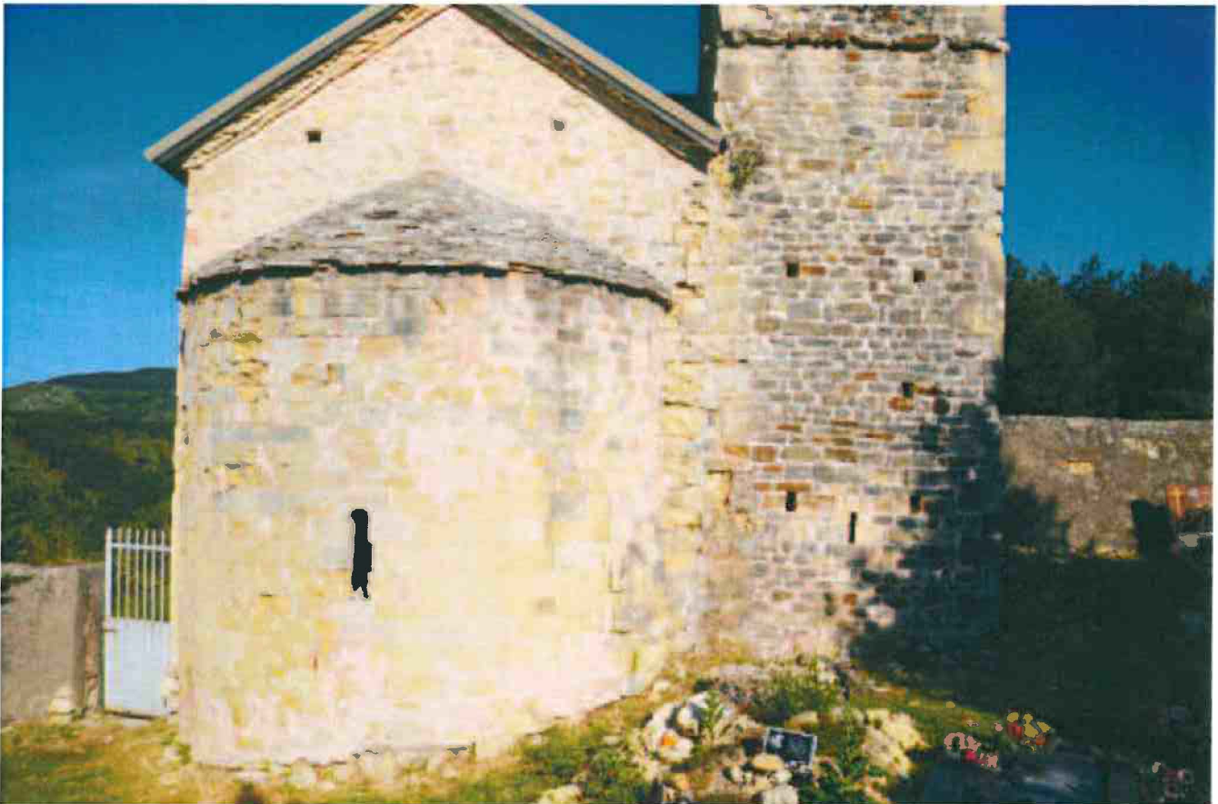
1-Vue sur le parement externe de l'abside.
