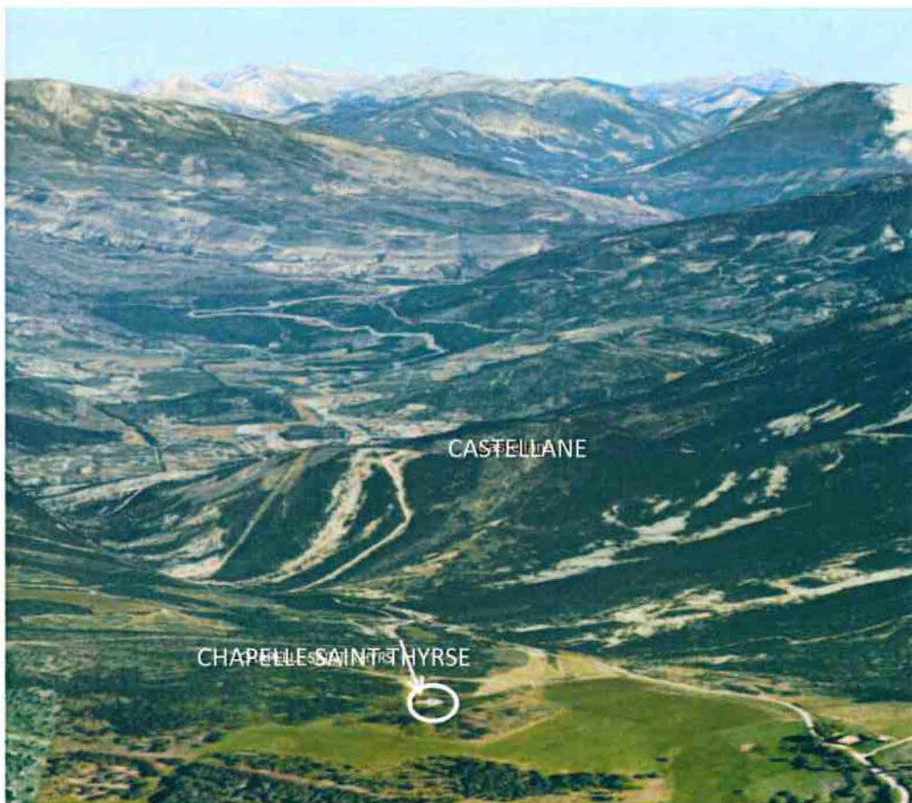
3-Vue de la chapelle Saint Thyrse, implantation dans l'environnement.
