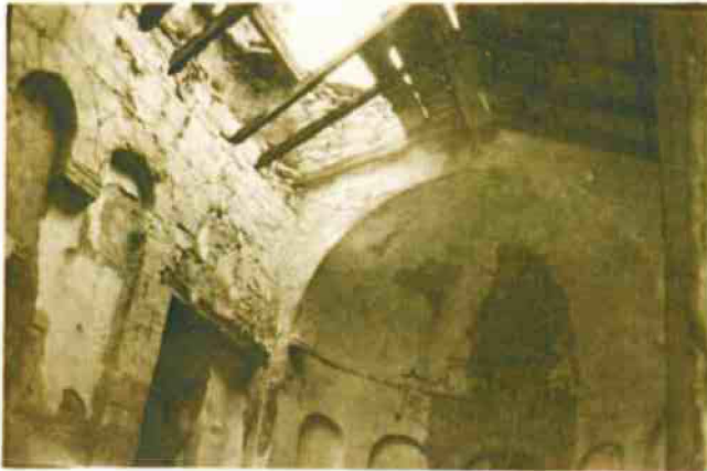
19-Vue de la toiture et de l'angle nord-est de la nef, 1942.
