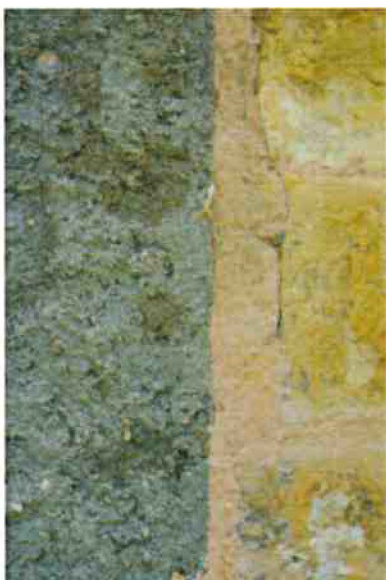
1-Jointoiement du coup de sabre entre le clocher et la nef
