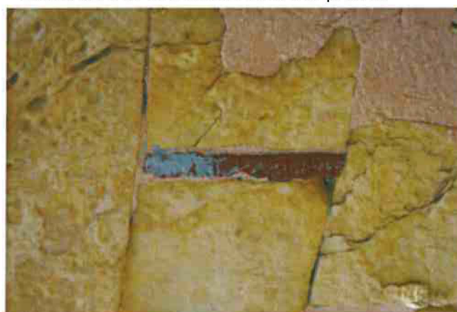
4-Inclusion de tuileau en terre cuite en calage des maçonneries.
