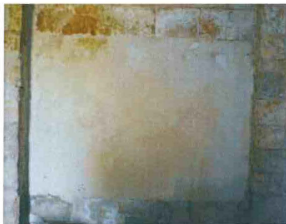
6-Aplat d'enduit en fond d'arcature, au nu du parement en pierre de taille (ragréage de parement altéré)
