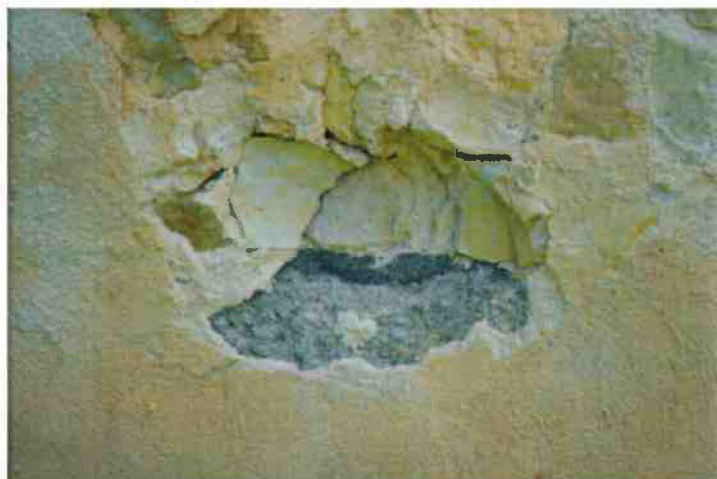
8-Vue de detail: comblement au ciment, enduit à la chaux hydraulique.
