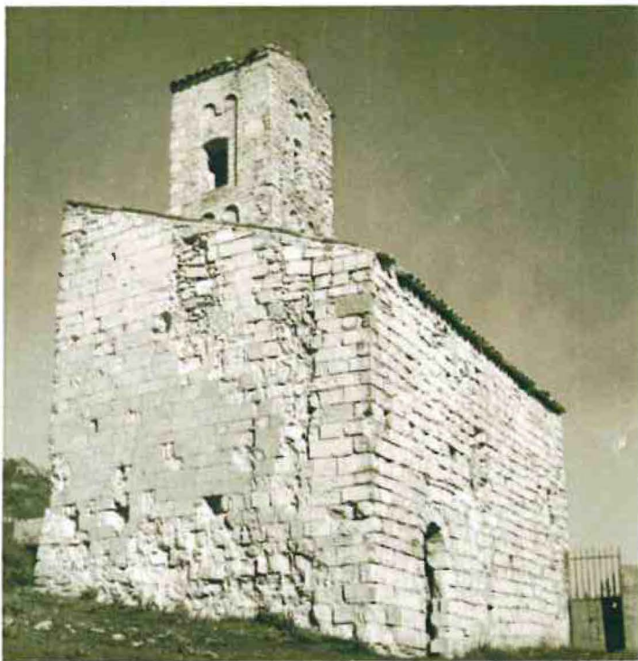
5-Vue ancienne sur le pignon occidental. On y distingue le bouchement de la baie et le coup de sabre entre la façade méridionale et la façade occidentale au niveau de la chaîne d'angle.
