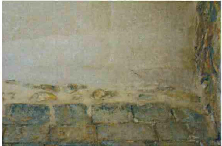
6-Liaison entre la voûte et l'arase des murs. La partie haute du mur est remontée en maçonnerie de moellons équarris. L'enduit à la chaux masque la reprise et permet d'adoucir la parie en raccord.
