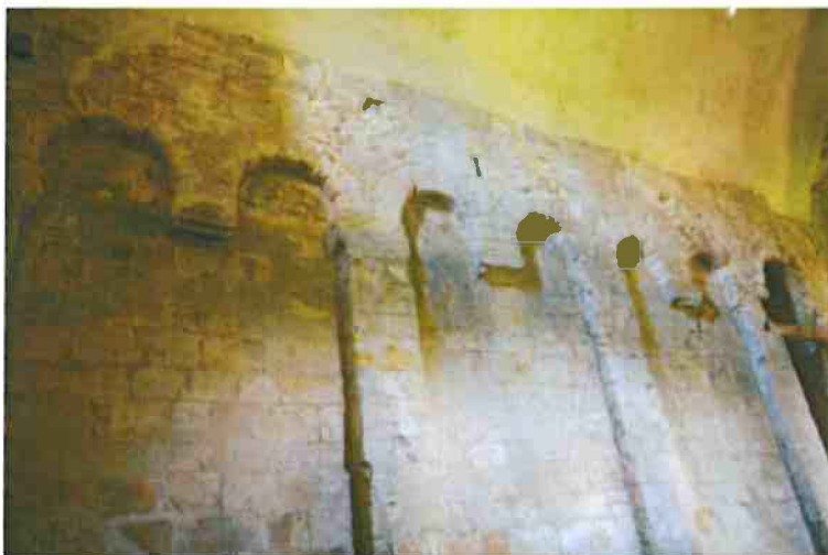
21-Vue sur le mur nord intérieur. Arcatures et bandes lombardes
