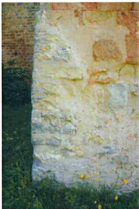
3-Parement éclaté, pierre non fendu, plus dure (non originelle), jointoiement large et ragréage au mortier de chaux hydraulique
