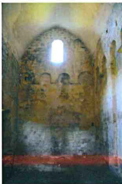
12-Vue de détail sur l'une des console engagée.
