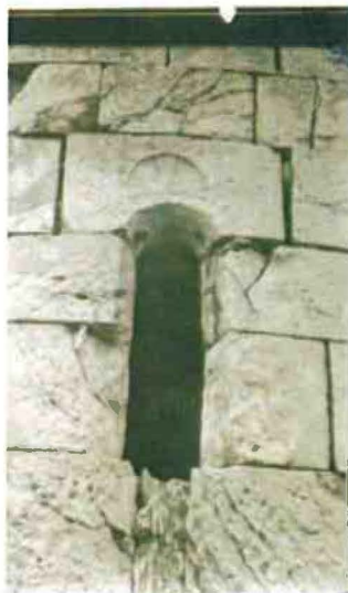
9-Détail: linteau sculpté de la baie de l'abside. Photo antérieure au vol.
