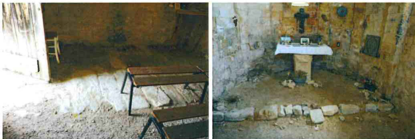
23-Vues sur le sol de l'église, au niveau de l'entrée de l'église et au niveau de l'abside.
