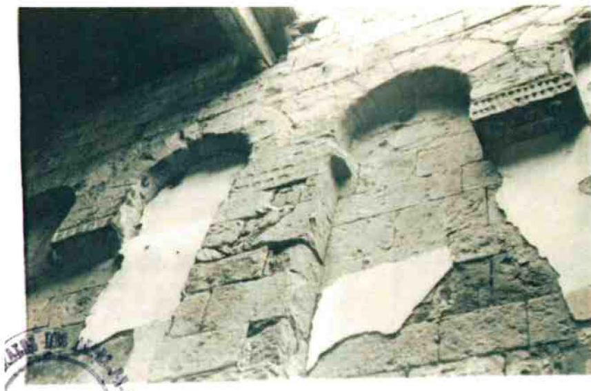
17-Vue de détail de l’arcature nord, 1942.
