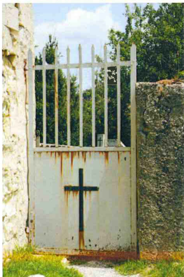
3-Porte d'accès au cimetière, scellement des gonds dans le mur de l'abside.
