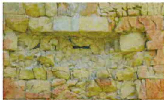
4-Diparition du parement, vestige d'encastrement de la tribune en bois, vue sur la maçonnerie interne en bloquage
