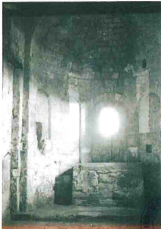
16-Vue sur l'élévation intérieure de l'abside, 1943.
