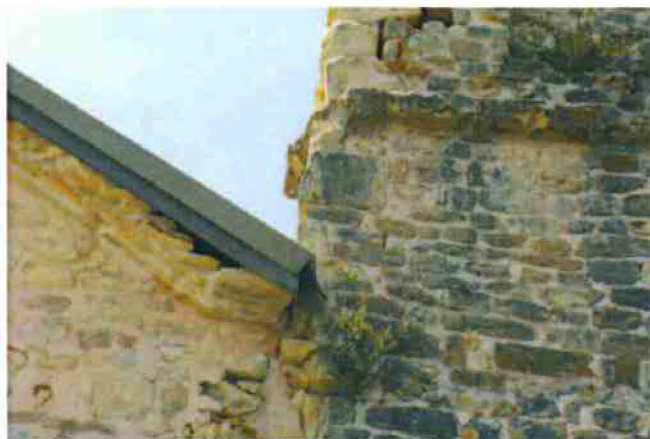
2-Liaisonnement entre le pignon oriental, l'abside et le clocher,écoulement des eaux en ruissellement le long du mur
