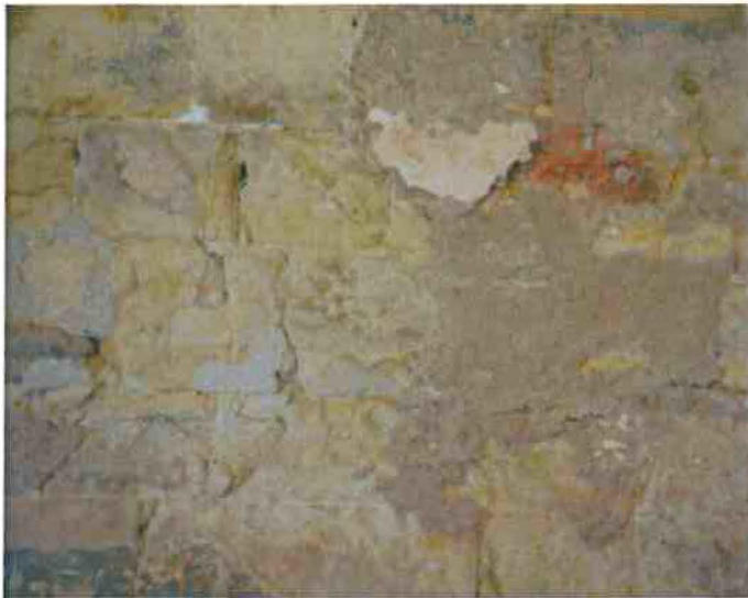
4-Enduit en ragréage, vestige d'un enduit ancien, traces de polychromie.
