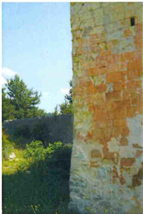
1-2-Chaines d'angle très abîmées: partie de parement en manque, pierres fissurées, éclatées. Ragréage et comblement des fissures et coup de sabre au mortier de chaux hydraulique.
