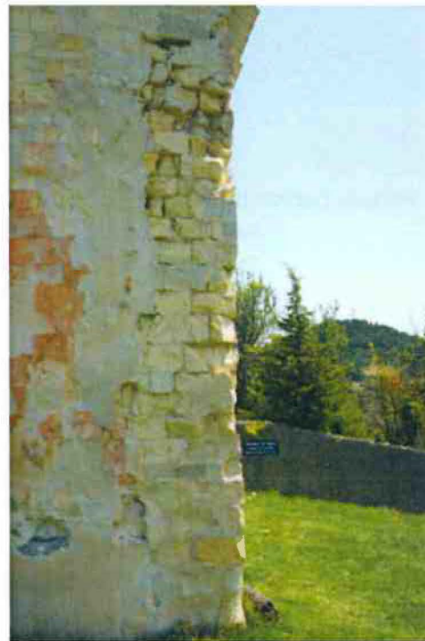
1-2-Chaines d'angle très abîmées: partie de parement en manque, pierres fissurées, éclatées. Ragréage et comblement des fissures et coup de sabre au mortier de chaux hydraulique.
