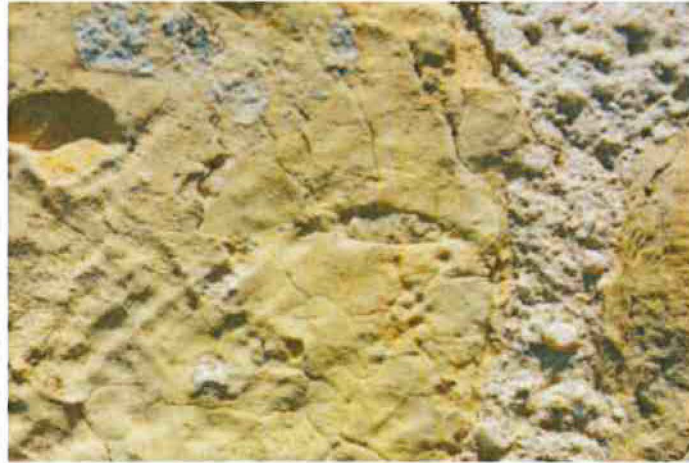
1-Vue de detail: comblement au ciment, enduit à la chaux hydraulique.
