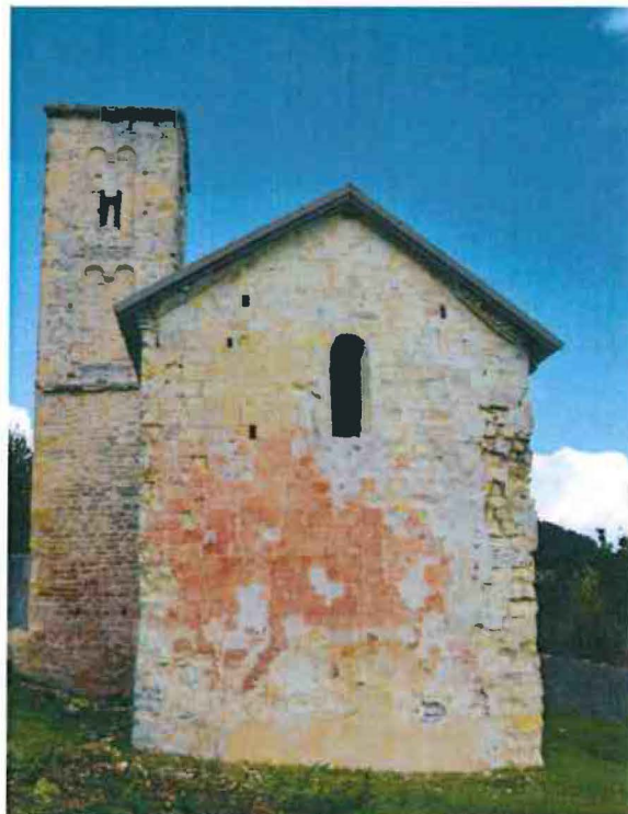
6-Vue actuelle sur le pignon occidental. On y distingue l'ouverture de la baie et le bouchement du coup de sabre au mortier.
