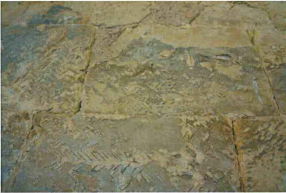
7-Disparition des surfaces taillées des pierres de parement.
