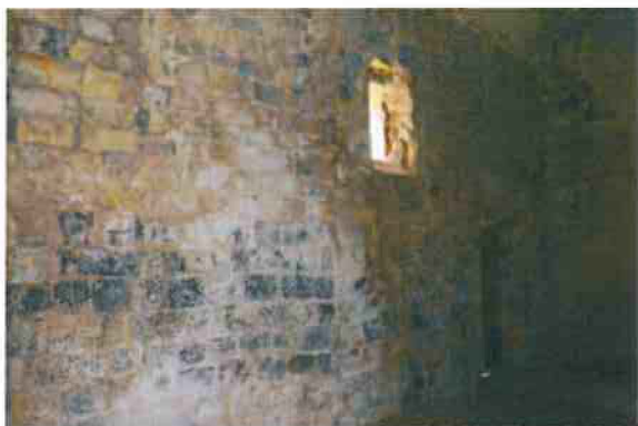
14-Vue sur le mur sud intérieur.
